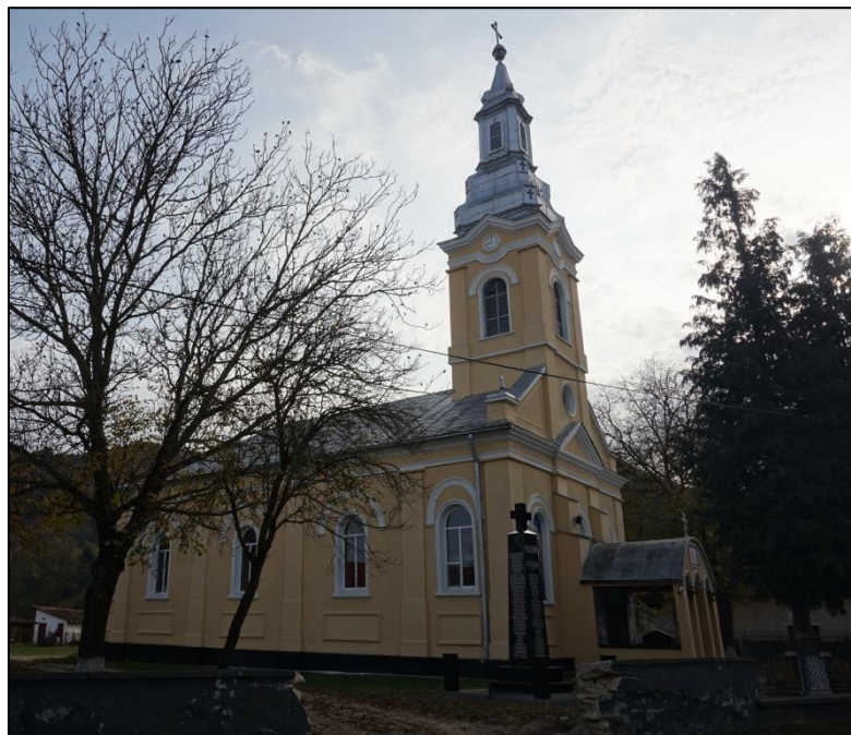
Fig. 4 – Biserica ortodoxă - vedere din lateral
